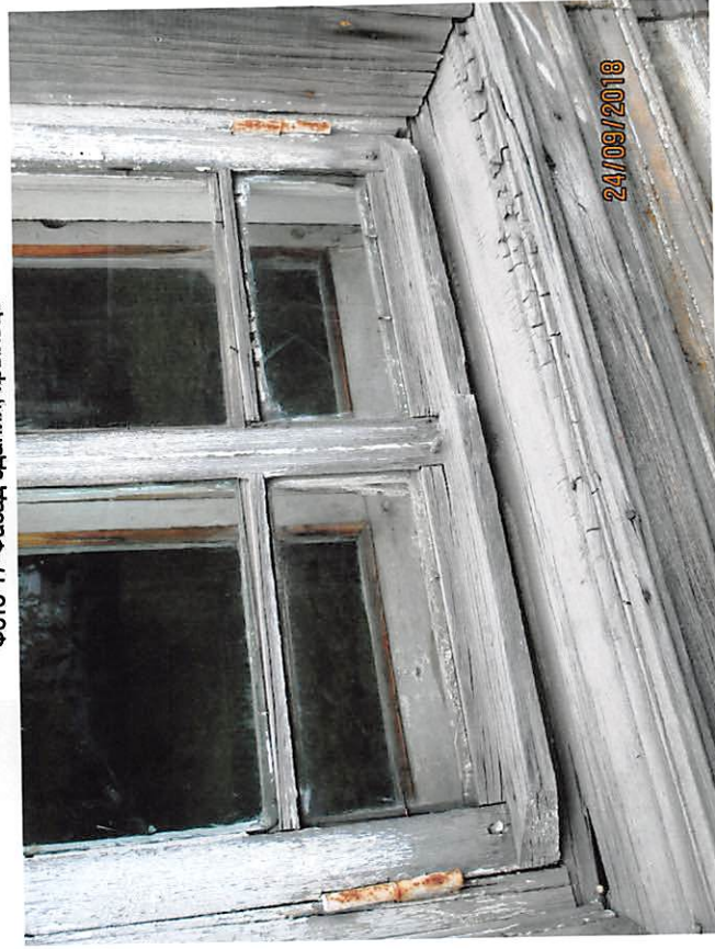
фото 19- Фасад здания, окна
