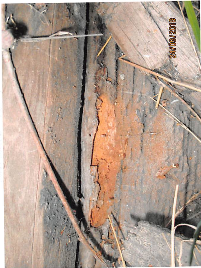
Фото 11-Фасад здания, стены
